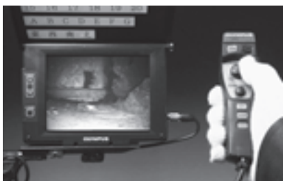
ファイバースコープによる空調ダクト内視調査
